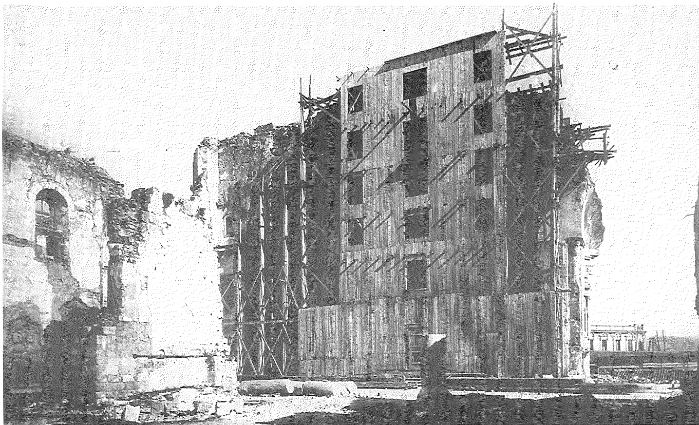
Fig. 6 - Messina, Duomo: inizio dei lavori di consolidamento all'abside centrale; a destra, ancora il vuoto dell'abside meridionale.
